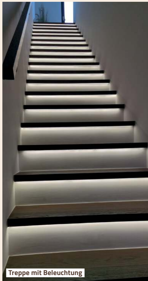
Stufenverkleidung aus Parkett, auf Gehrung geschnitten Weitere Optionen möglich
